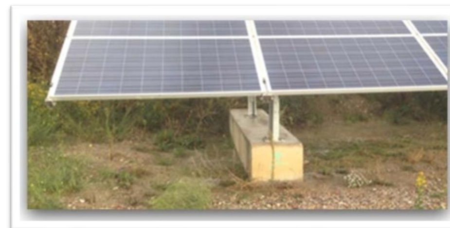
Photographie 1. Exemple de longrine / Réalisation URBASOLAR (terril de Bramefan, Fuveau)
